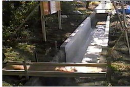
写真-8 施工完了状況
