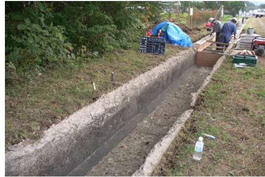
写真-3 施工前の用水路
