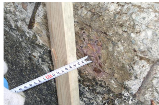
写真-5 はつり工 未中性化域確認状況
