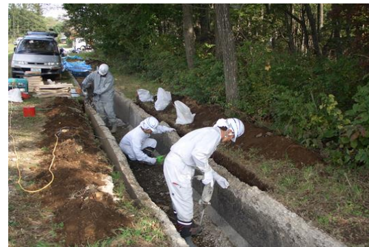
写真-4 はつり工の様子
