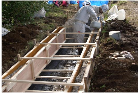
写真-7 断面修復工の様子
