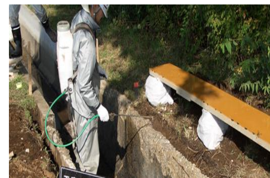
写真-6 表面含浸工 EP 保護材塗布状況(噴霧による塗布)
