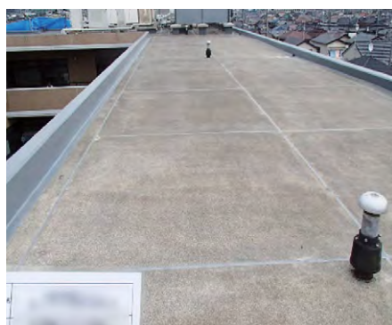
ビル / 屋上駐車場
